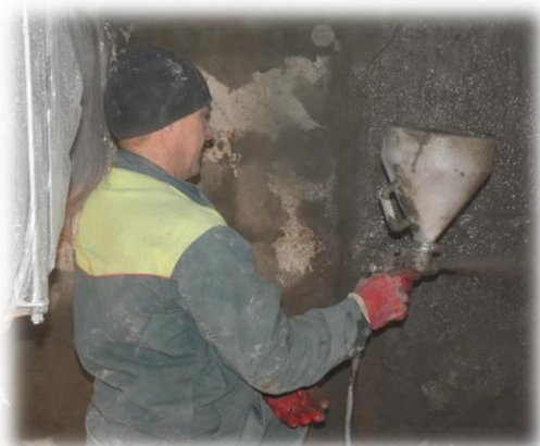
Рис. 2.1.4 Механический способ нанесения состава КАЛЬМАТРОН
