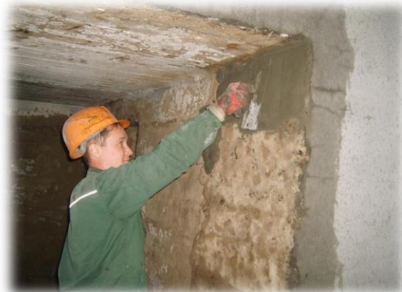
Рис. 2.1.5 Ручной способ нанесения состава КАЛЬМАТРОН
