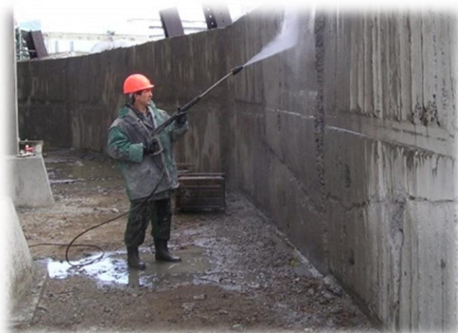
Рис. 2.1.1 Очистка и увлажнение поверхности гидромонитором
